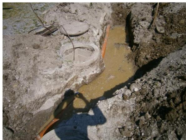
In mehreren Arbeitsstunden wurde dann der notwendigste Teil der Kanalrohre durch neue und entsprechend dimensionierte Rohre ersetzt, sodass der Betrieb auf der Karrer Alm wieder ohne Probleme fortgeführt werden konnte.
