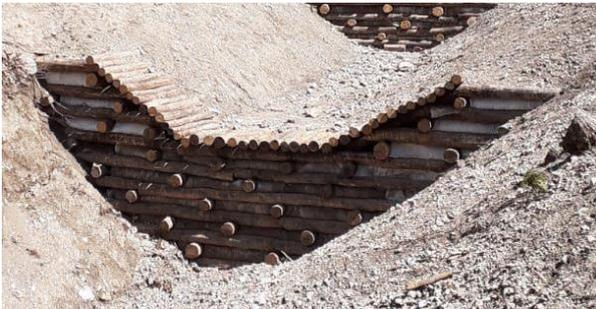
Im Bereich des Lehnentalgrabens werden sieben Konsolidierungssperren errichtet, um die Sohle und Bacheinhänge zu stabilisieren bzw. eine erneute Geschiebemobilisierung zu unterbinden. Aktuell wird gerade an der sechsten Sperre gearbeitet.
